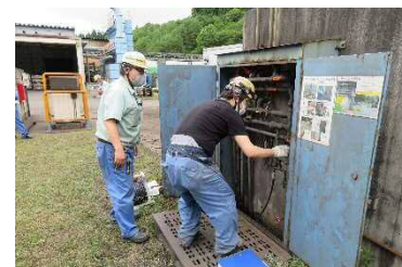
散水栓による廃棄物飛散防止訓練
